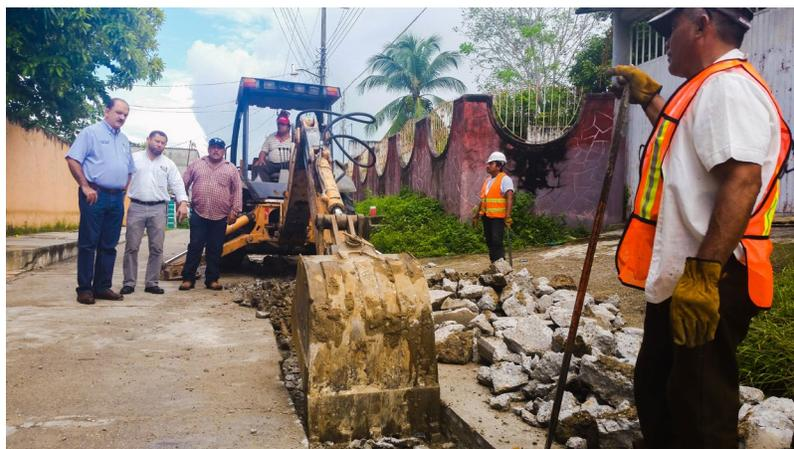
De igual forma se llevaron a cabo trabajos de **bacheo de 771 metros cuadrados con concreto hidráulico y 850 metros cuadrados de bacheo de mezcla asfáltica en diversas calles de la ciudad.**
